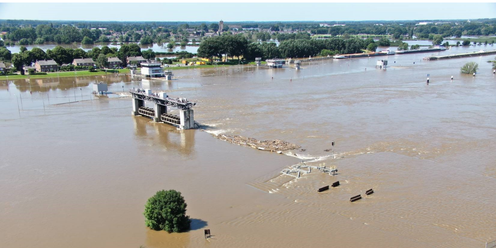
Afbeelding: Hoogwater Maas bij stuw Sambeek (bron: RWS Droneteam)
