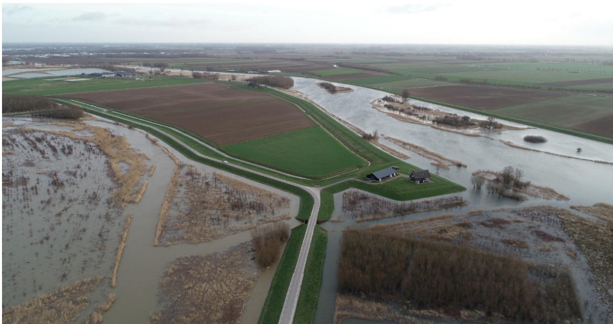
Figuur 9 Ondergelopen Noordwaard op 11 februari. (Bron: RWS CIV)
