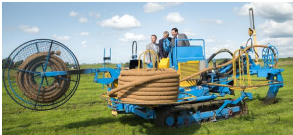
Aanleg van onderwater drainage
