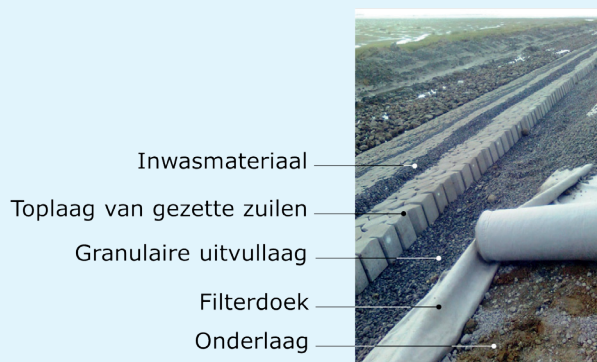
Afbeelding 1: Aanleg van een steenzetting waarbij verschillende lagen zichtbaar zijn
