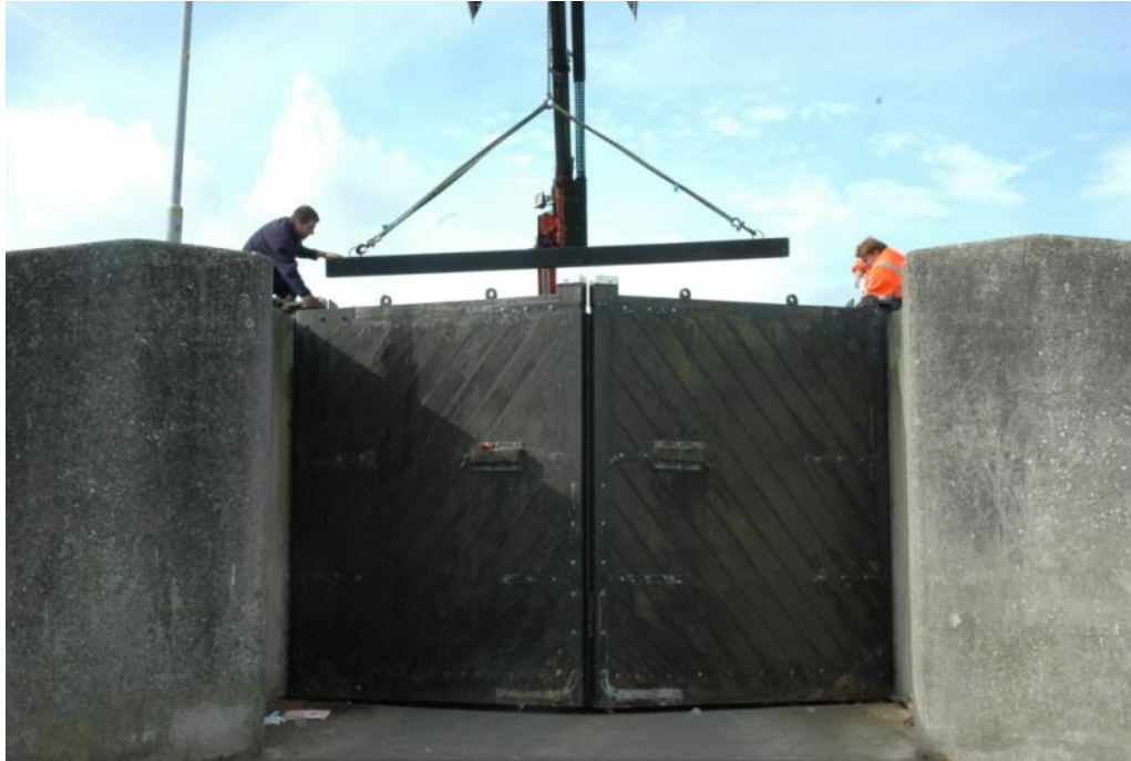
Figuur 5 Proefsluiting puntdeuren buitenzijde (bron: [Ref. 1])
