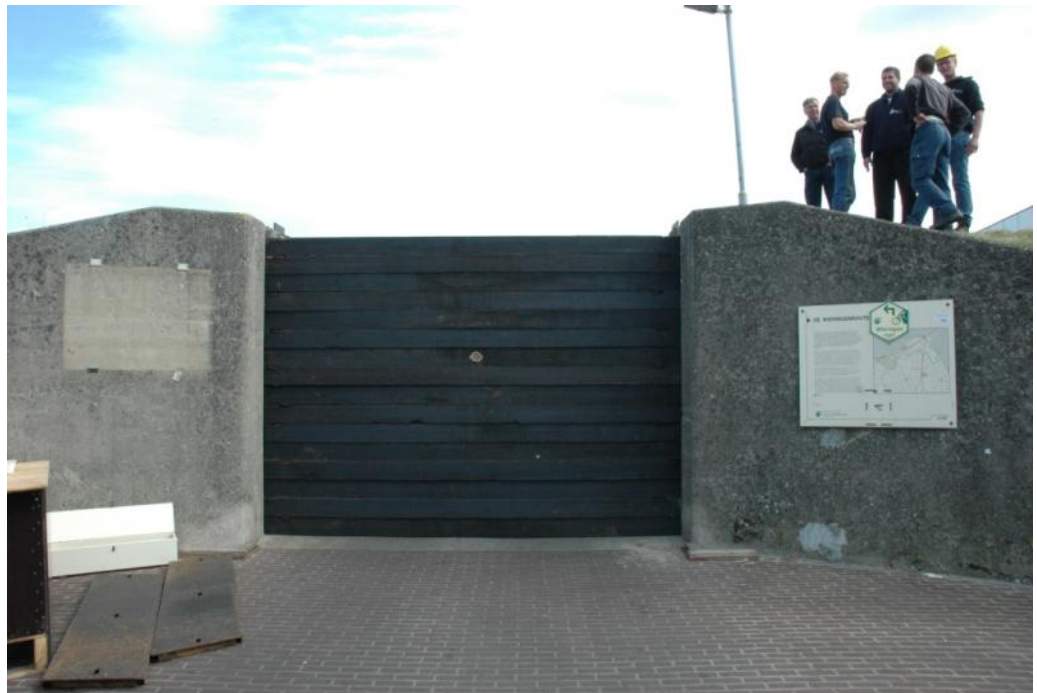
Figuur 6: Proefsluiting schotbalken binnenzijde (bron: [Ref. 1])
