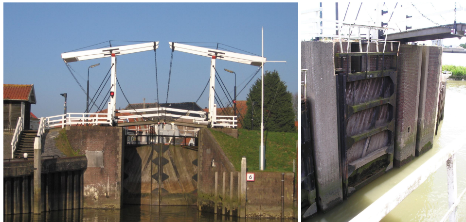
Figuur 10 Keersluis Schoonhoven, aanzicht (links, keermiddel gesloten), vloeddeur (rechts, keermiddel geopend, archiefbeeld)
