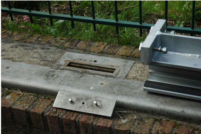
Figuur 6 Bevestiging staanders
