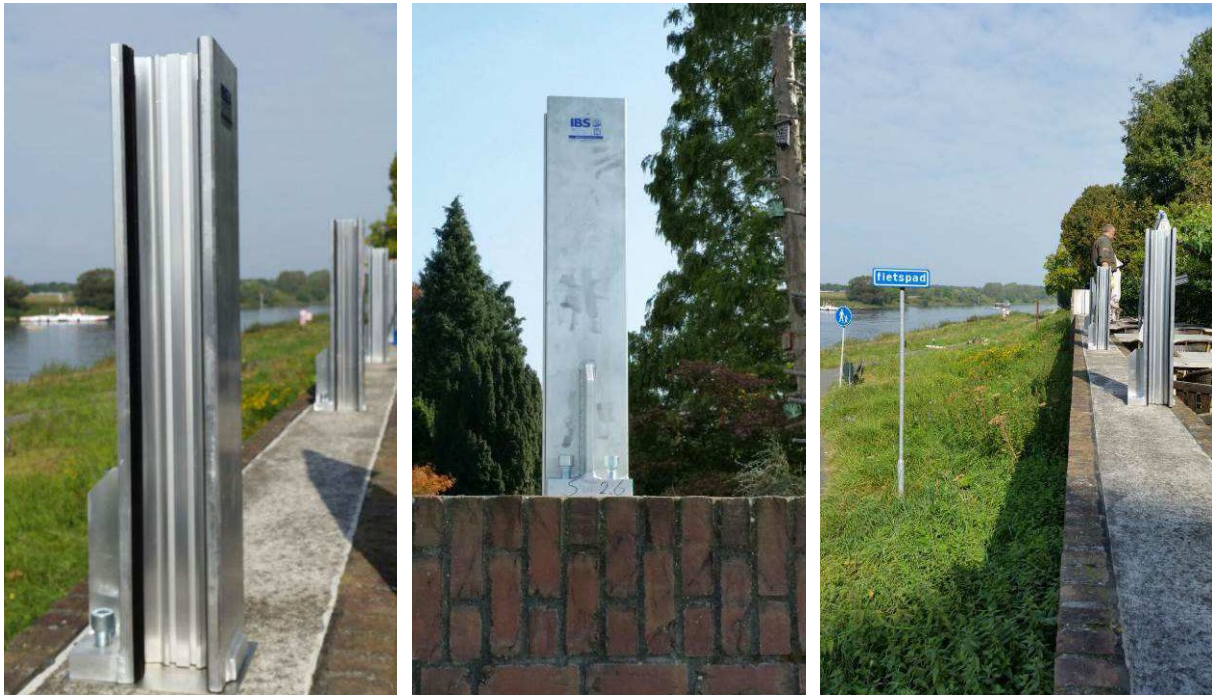
Figuur 12 staanders van de demontabele wand
