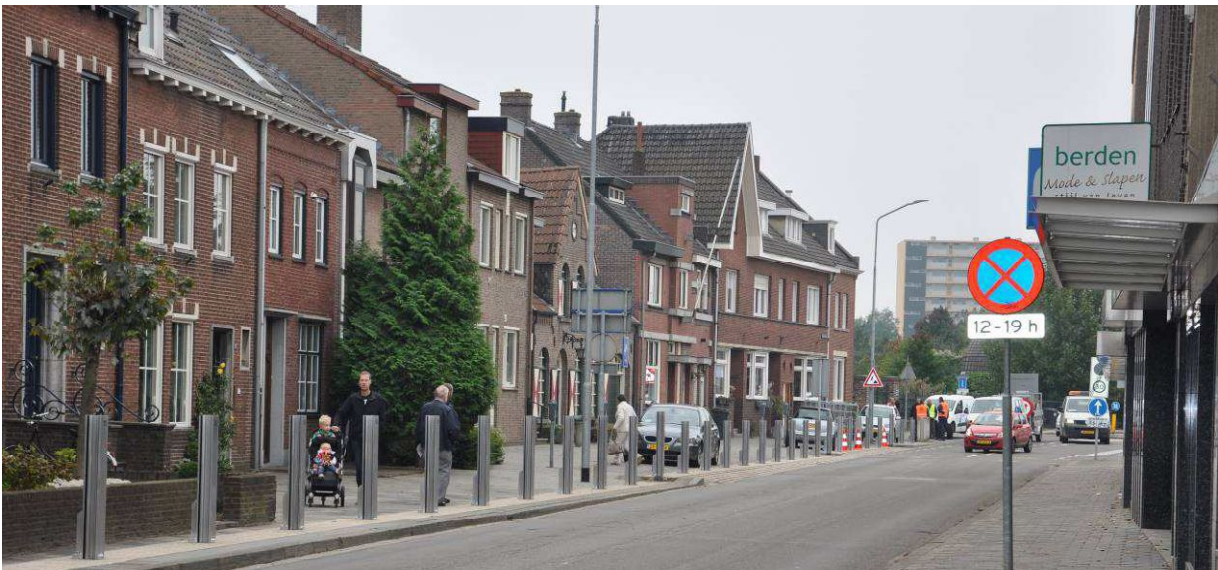
Figuur 14 Demontabele wand Pontanusstraat Blerick
