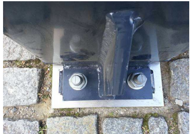
Figuur 5 Draadeinden met plaatjes aan onderzijde staanders (links); inkeping aan bovenzijde draadeind die overeenkomt met richting plaatje (rechts)
