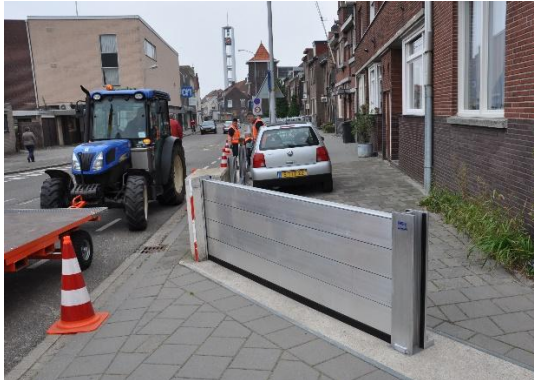
Figuur 3.7 Schotbalken geplaatst
