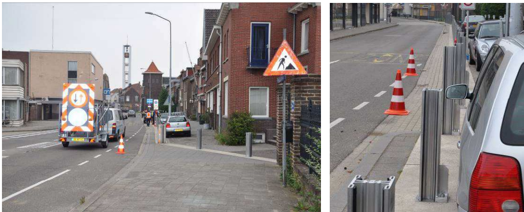
Figuur 15 Bordenwagen aan begin traject demontabele wand (links) en geparkeerde auto (rechts)
