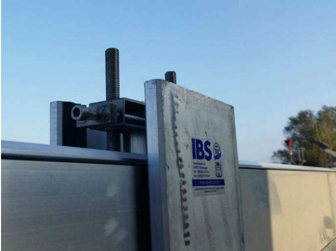
Figuur 13 Klemsysteem schotbalken in verticale richting
