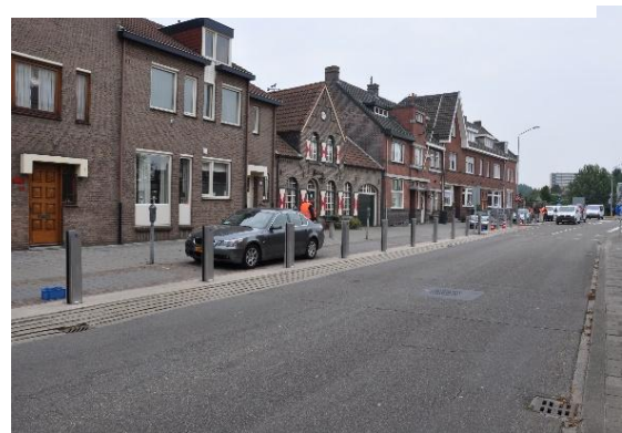
Figuur 3.6 Staanders geplaatst
