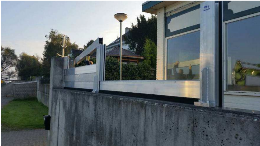
Figuur 10 Plaatsen van de schotbalken
