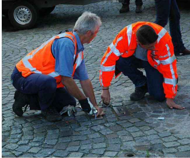
Figuur 3 Het demonteren van de afdekkapjes van de fundaties
