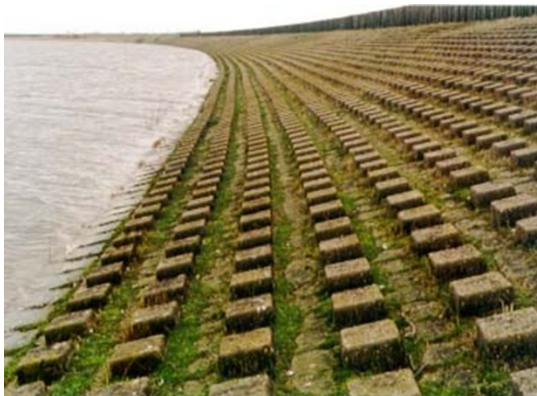
Figuur 6.7 Voorbeelden van ruwheidselementen op betonblokken
