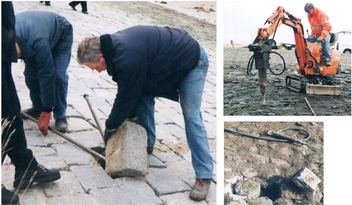
Figuur 3.1 Het openbreken van de steenzetting is vrij eenvoudig en levert een schat aan informatie
