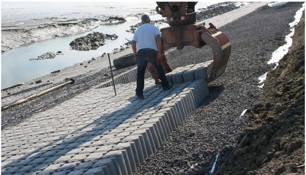
Figuur 4.1 Aanleg steenzetting van Hydroblocks
