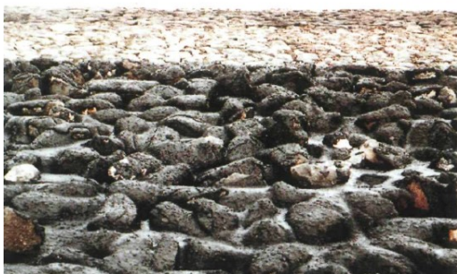
"Vol en zat" gepenetreerde breuksteenoverlaging (7)
