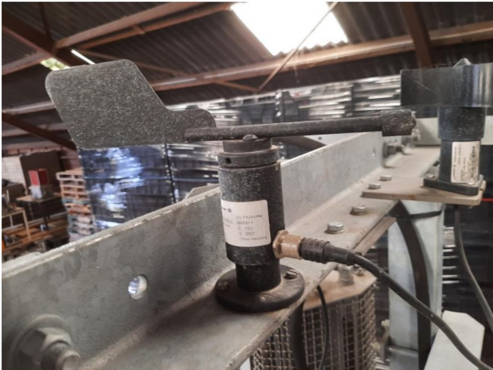
Actuator met ingebouwde sensor stuurt en meet de luchtrichting.
