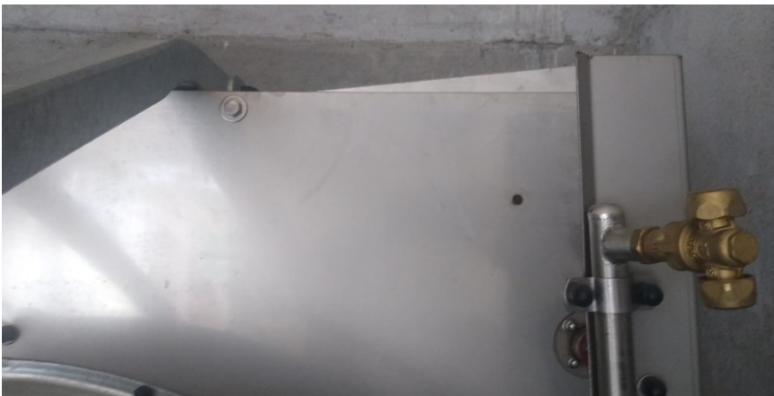
Figuur 7 Bovenste foto: Luchtgeleidingsklep bovenop de mast (luchtcassette) dient open te staan Onderste foto: Afbeelding van gesloten luchtgeleidingsklep
