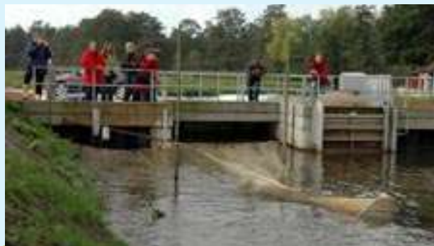
Netconstructie gemaal Meerweg
