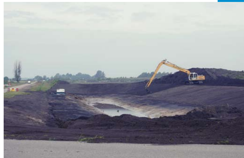
Werkzaamheden bij Wetering-Oost (Foto: Waterschap Reest en Wieden)
