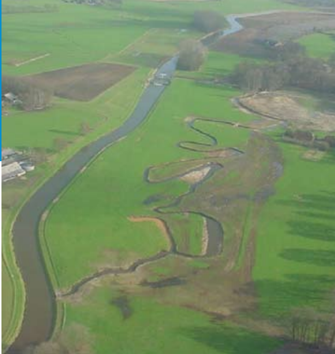
Bypass en vispassage Velhorst bij de Berkel (Foto: Waterschap Rijn en IJssel)
