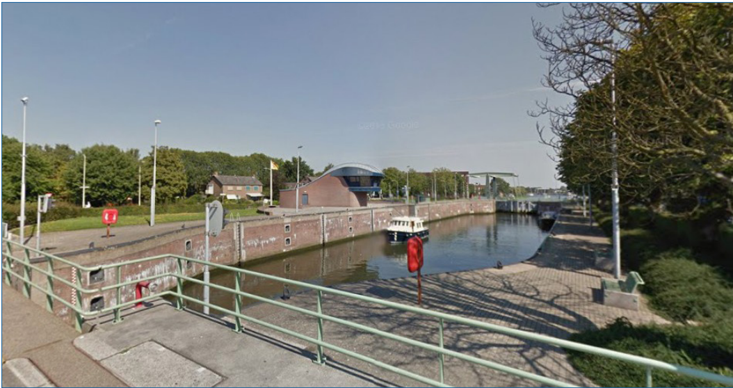
Figuur 25 Zicht op de sluiskolk van zuid naar noord.
