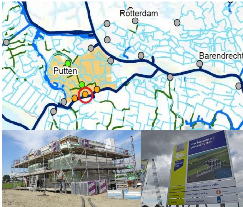
Gemaal putten, werk in uitvoering (augustus 2017)
