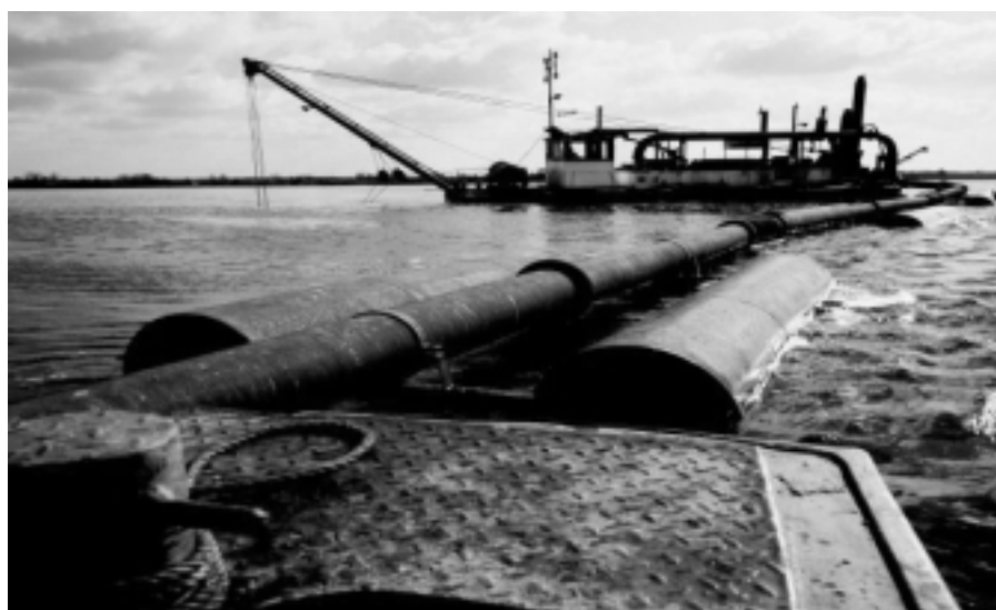
Hydraulisch baggeren in het Ketelmeer
