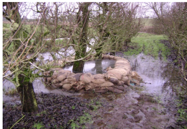
Met zandzakken opgekiste wel in Bommelerwaard (foto: Tom Veenhoff, Waterschap Rivierenland)
