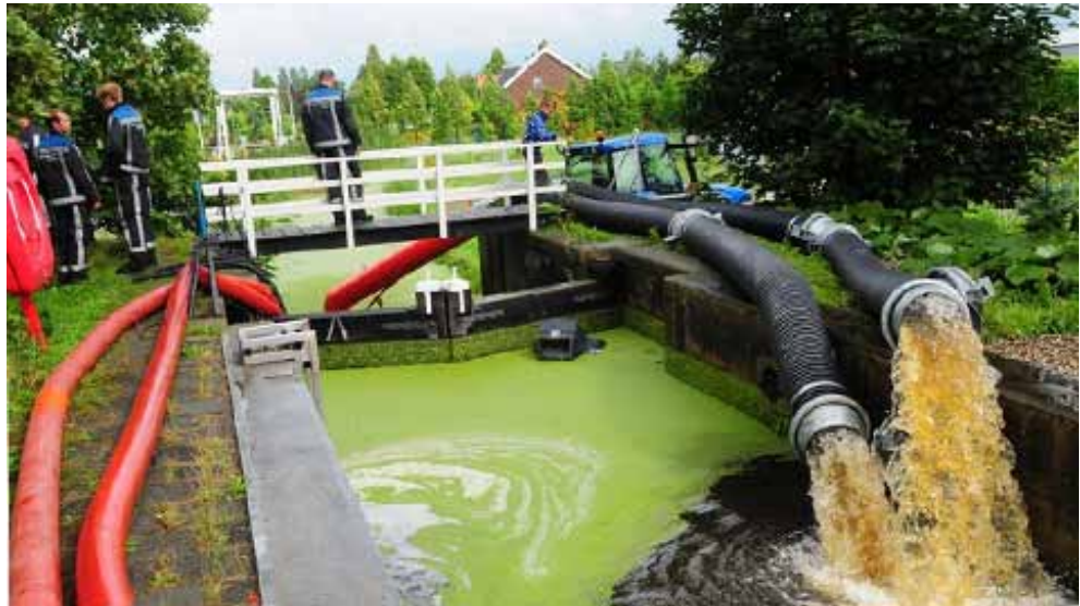
Figuur 7. Brandweer aan het werk in polder Rijnveld (bron www.westonline.nl )
