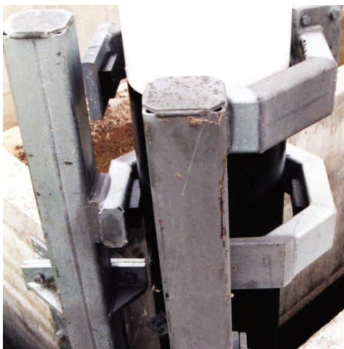
Verankering woningen aan paal
