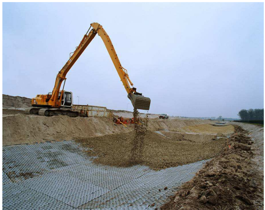
Figuur 3.21 Kunstmatig beddingmateriaal wordt aangebracht in de Grote Molenbeek (Foto: beeldbank RWS).
