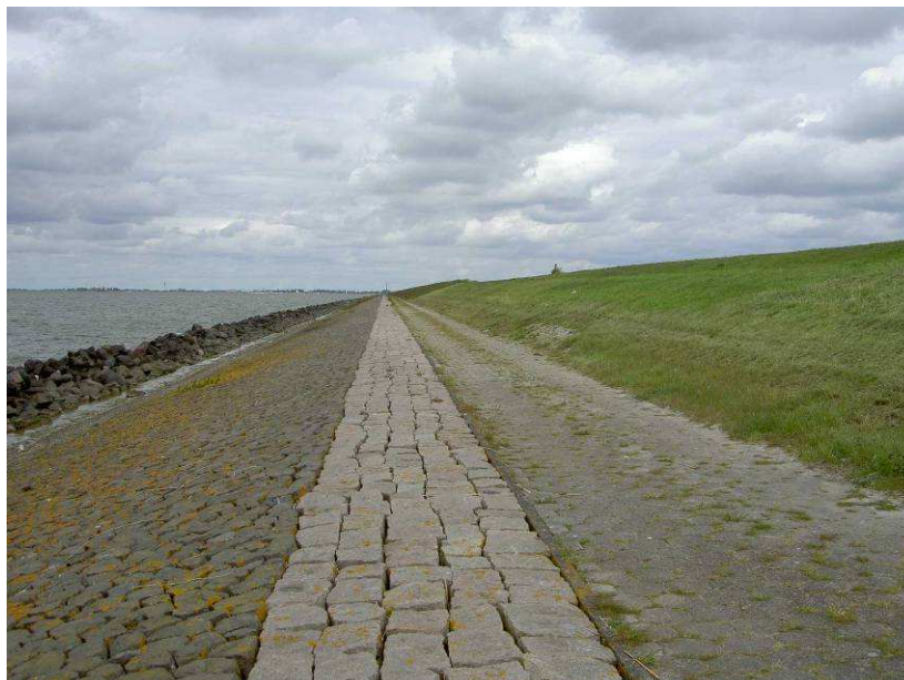
Figuur 4.16 Voorbeeld niet-natuurlijke oeververdediging Noordermeerdijk. (Foto: RPS)
