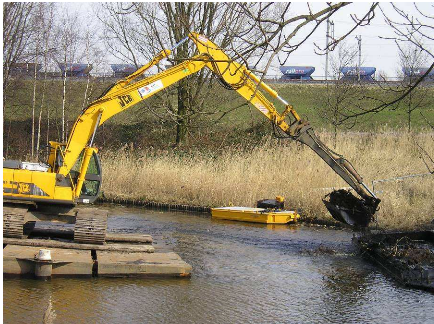
Figuur 4.14 Waterbodemmonsters kunnen goed tijdens baggerprojecten worden genomen (foto: RPS).
