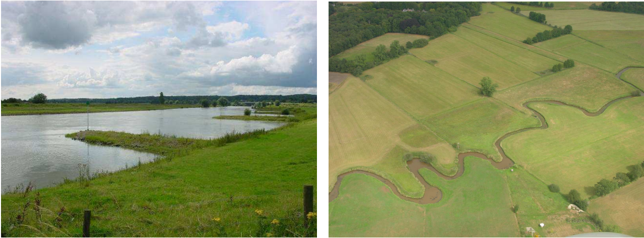
Figuur 3.30 en 3.31 Beperking meandering door kribben en oeververdediging (links, foto: RPS) en vrije meandering van de Reest in het beekdal (rechts, foto: waterschap Reest & Wieden).
