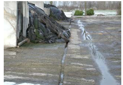
Foto 9: inkuilen buiten de silo
