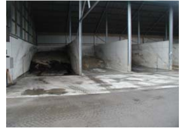
Foto 10: overkappen van silo's
