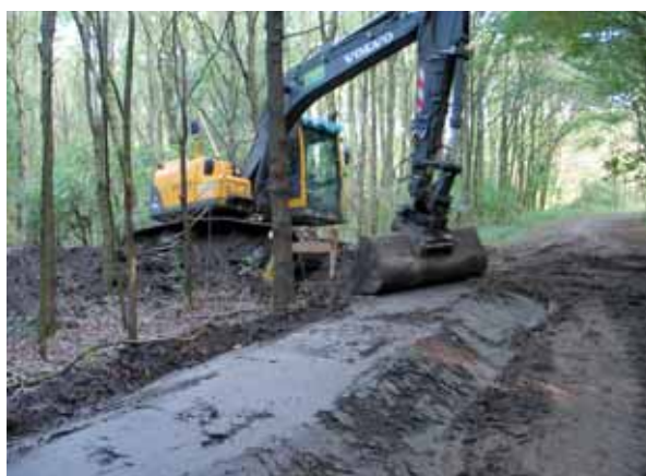
Inrichting van de compartimenten door de aanleg van kleikades.
